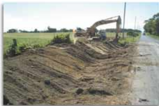
Excavation dans le cadre du PSTC, à Port Hope.
