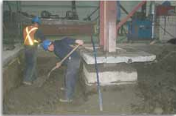
Excavation autour d'une colonne d'un bâtiment du site d'Anvil Way.
